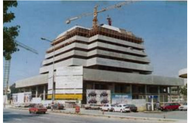
Καρδιοχειρουργικό Κέντρο Ωνάσιο, Αθήνα - Φωτογραφία κατά την διαδικασία κατασκευής
