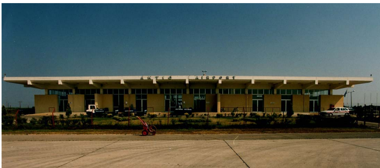
Επιβατικός σταθμός αεροδρομίου Ακτιου
